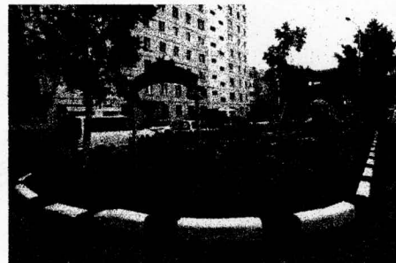
Ремонт дворов и внутриквартальных проездов
