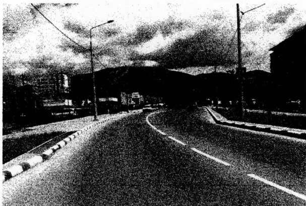
Реконструкция дорожного покрытия
